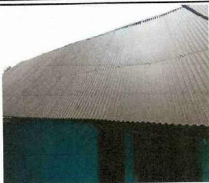
Foto 1: Se observa la necesidad de cambio de laminas, ya que con el paso del tiempo se han deteriorado.
